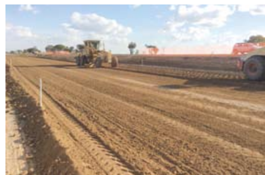
Obras iniciais incluem ampliação e duplicação da rodovia
