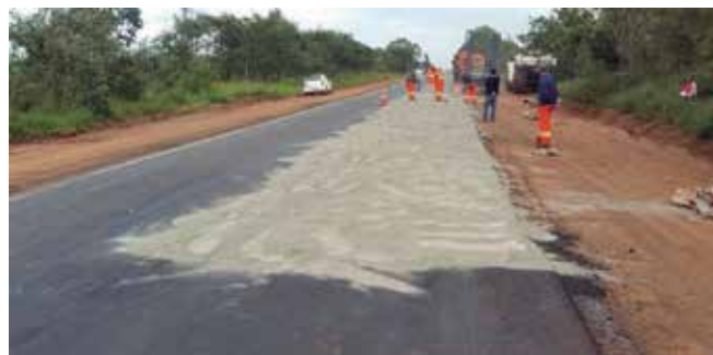
Preparo com dosagem de cimento para reciclagem de pavimento
