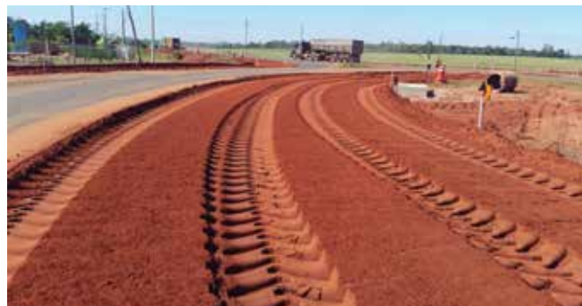
Estrutura de pavimento após reciclagem
