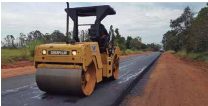
Compactação de massa asfáltica (CBUQ) pelo rolo compactador
