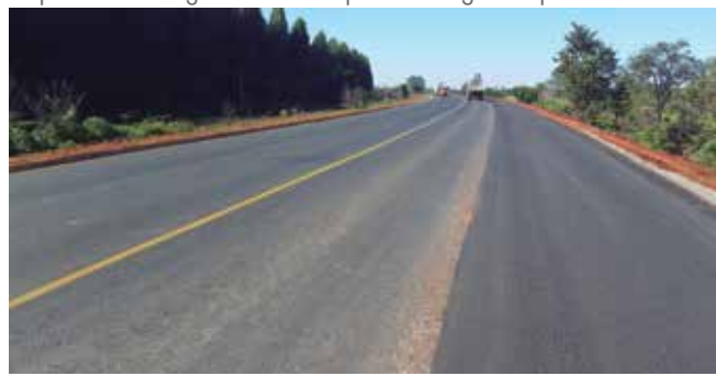
Pavimento asfáltico do acostamento concluído
